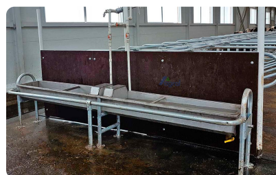
Групповая поилка без подогрева для КРС и МРС из стали AISI 2
