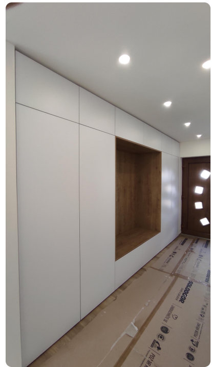
Vstavané skrine doornet na panty s PUSH systémom otvárania.
